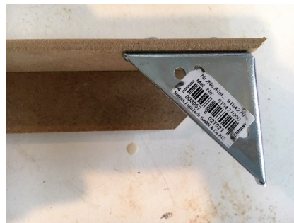
Plaatsing hoekprofiel ten opzichte van MDF 45 graden hoek.
