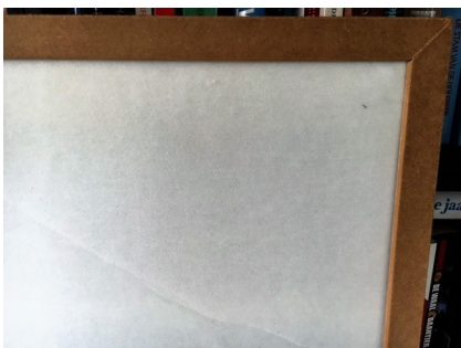
Plaats de Akotherm plaat onder het hoekprofiel, rustend op onderzijde MDF
