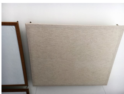
Het bijgeleverde kabelmontagesysteem zorgt vervolgens voor een perfecte op-hanging. Span aan de bovenzijde de stof goed vast. (naald en draad van vlieger-touw
