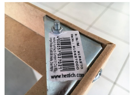
Bepaal een juiste plaatsing aan plafond mbv boutje en moer op het hoekprofiel
