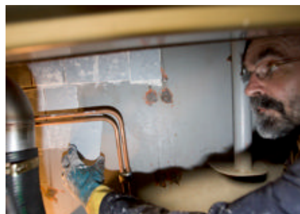
Sandwich-ontdreunen van een motorruimte
